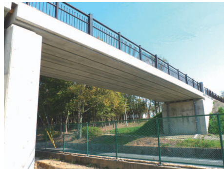
山田池公園橋梁 (大阪府枚方市)
