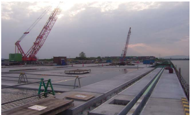
名古屋港鍋田ふ頭岸壁 (愛知県)
