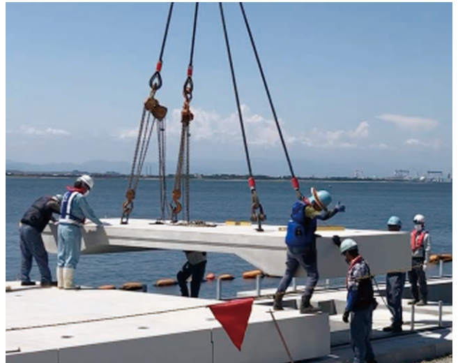
※施工実績：大口埠頭改修工事
