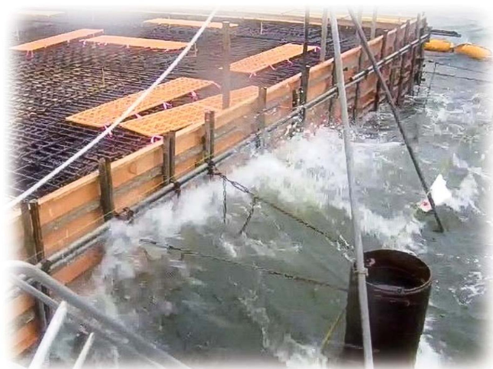
従来工法(場所打ち)の施工イメージ
