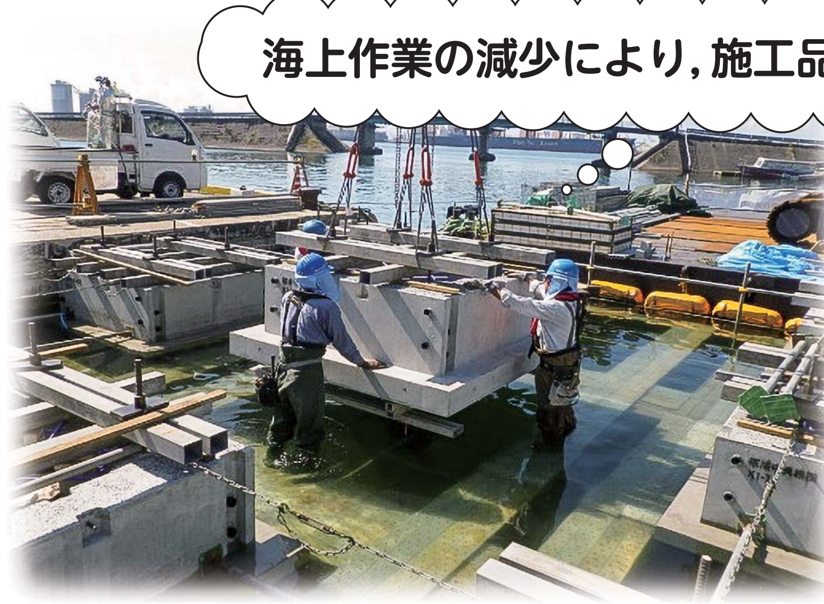
本工法(プレキャスト)の施工イメージ
