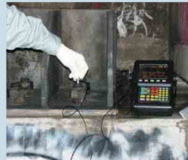
□ 超音波によるアンカー長測定
