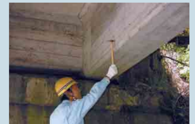
□ 打音調査によるコンクリート変状調査
