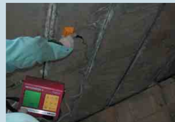
□ 電磁誘導法による内部鋼材探査
