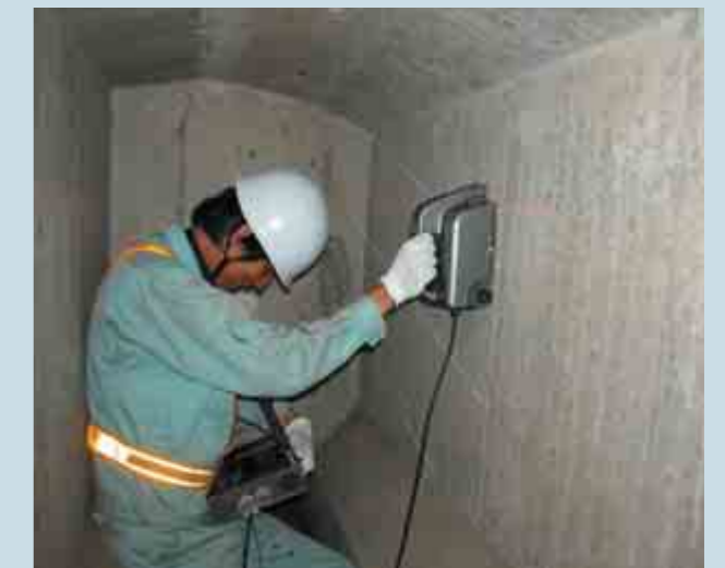
□ RCレーダーによる内部鋼材探査
