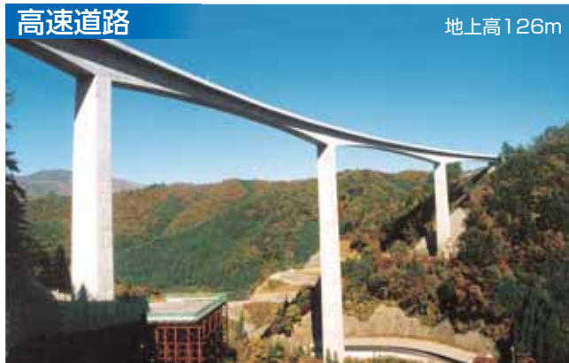
鷺見橋(岐阜県)【東海北陸自動車道】
