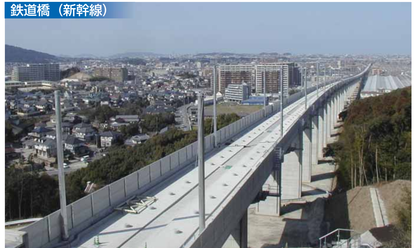
第2地下道Bv(福岡県)【九州新幹線】
