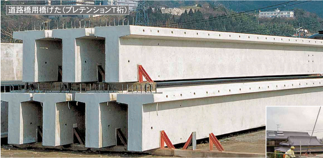
道路橋橋げた用セグメント(コンポ桁)
