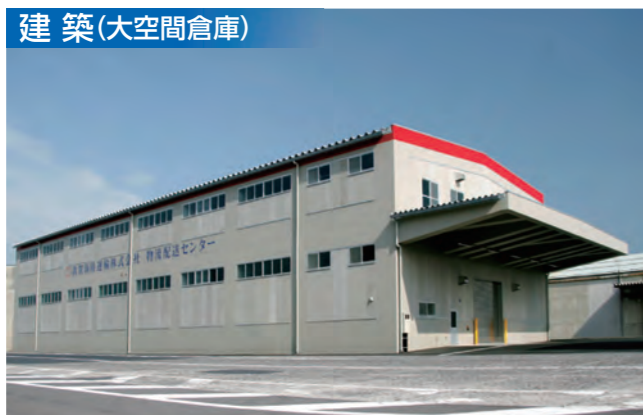
敦賀海陸配送センター(福井県)
