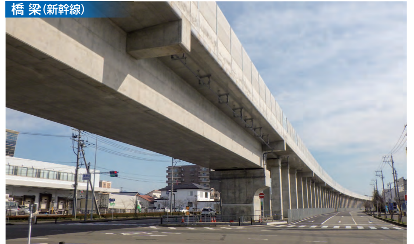
福井高柳高架橋(福井県)【北陸新幹線】
