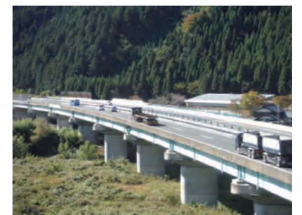
日野川橋床版更新工事(福岡県)
