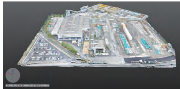
点群データ(日本ピーエス本社)
