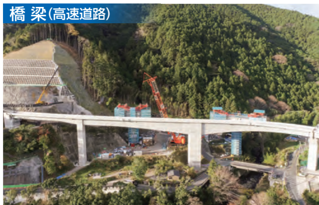
河津IC Aランプ橋(静岡県)
