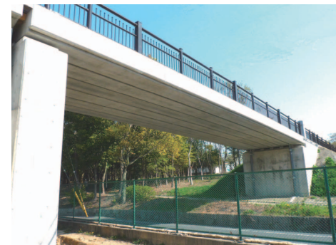
山田池公園橋梁 (大阪府枚方市)
