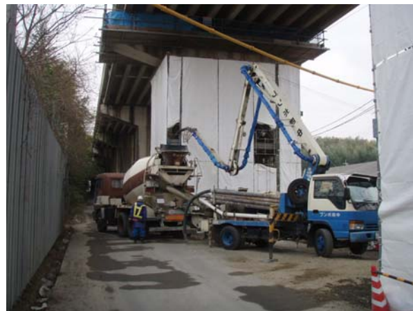
写真-3 コンクリート打設状況
