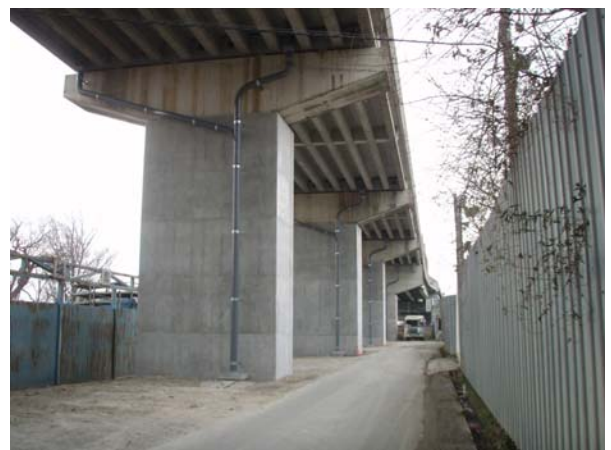
写真-1 完成写真
