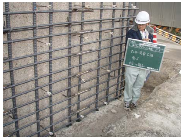
写真-2 主筋のフーチング定着
